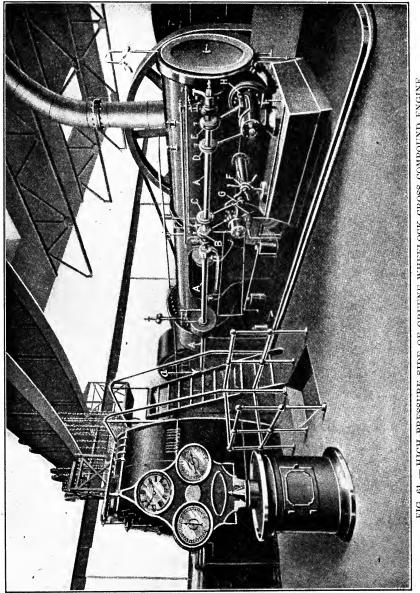
FIG. 61. — HIGH-PRESSURE SIDE OF GREENE-WHEELOCK CROSS-COMPOUND ENGINE.
