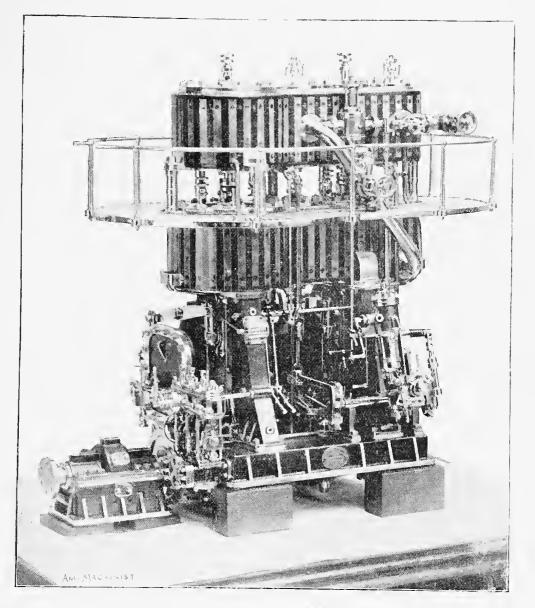
CHASE'S QUADRUPLE-EXPANSION MARINE ENGINE.
