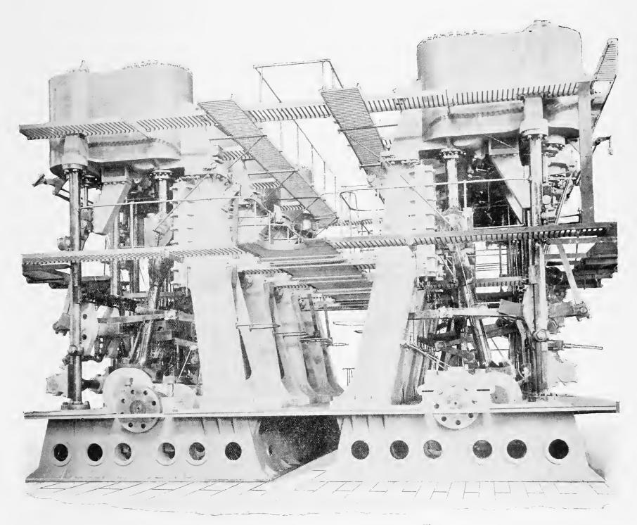
QUADRUPLE-EXPANSION ENGINES OF THE STEAMER NORTH WEST.
