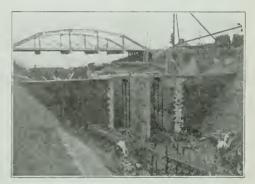
FIG. 2. CONTROLLING AND INTAKE SLUICES OF SIOUX FALLS SPILLWAY UNDER CONSTRUCTION.
