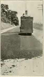
V. ROLLING THE LAYER OF FIBERED ASPHALT MIXTURE AS SPREAD. NOTE CHARACTER OF TAMPED EDGE ALONG THE SIDES AND THAT ROLLING DOES NOT CAUSE THE ASPHALT TO CREEP IN ANY DIRECTION.
