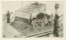
ALLIS-CHALMERS TRACTOR TRUCK DUMPING SEVEN TONS OF GRAVEL ON ROADBED OF CONCRETE ROAD. NOTE THE DRIVER OPERATING THE DUMP BODY FROM SEAT.
