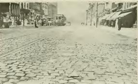
OLD BELGIAN BLOCK OF TRAP ROCK ON BROAD STREET, ELIZABETH, N. J., AS IT EXISTED BEFORE 1915, SHOWING UNEQUAL SETTLEMENT OF STREET, DUE TO INSUFFICIENT FOUNDATION.
