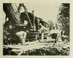
LAYING PLANK TRACK FOR ROLLERS UN-DER MACHINE IN PREPARATION FOR MOVING UP.
