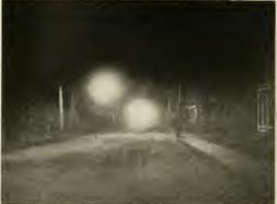
FIG. 7. NIGHT VIEW OF FOWLER STREET, SHOWING EYE-SUSPENSION UNITS, EQUIPPED WITH 20-IN. CONCENTRIC RE-FLECTORS. PRISMATIC REFRACTORS, AND 250-C.P. EDISON MAZDA SERIES LAMPS.
