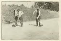
111. FINAL SWEEPING OF THE DUST FROM THE SURFACE READY TO LAY FIBERED ASPHALT COVER.
