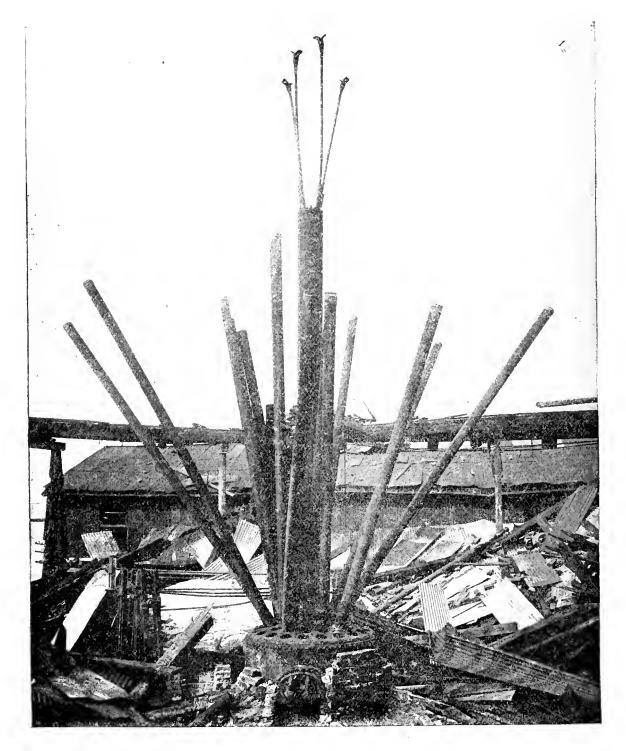
FIG. 2.— SHOWING THE EXPLODED BOILER IN DETAIL.
