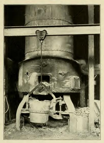
FIG 5. A TROLLEY LADLE IN POSITION AT THE CUPOLA.
