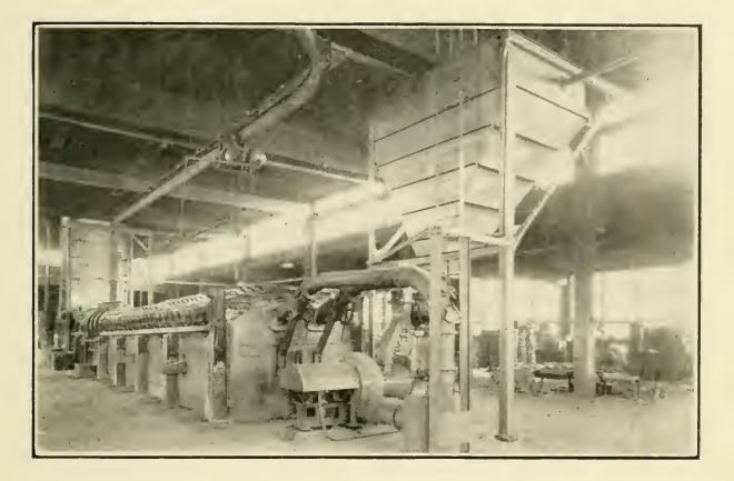
FIG. 237a.—25-TON HOPPER SYSTEM PULVERIZED-COAL-FIRED FURNACE.
