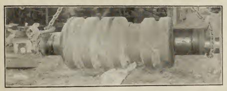
FIG. 1.-CAST STEEL ROLL. WEIGHT 8 TONS.
