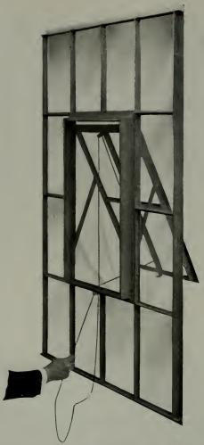
TYPE OF STEEL SASH USED FOR FACTORIES
